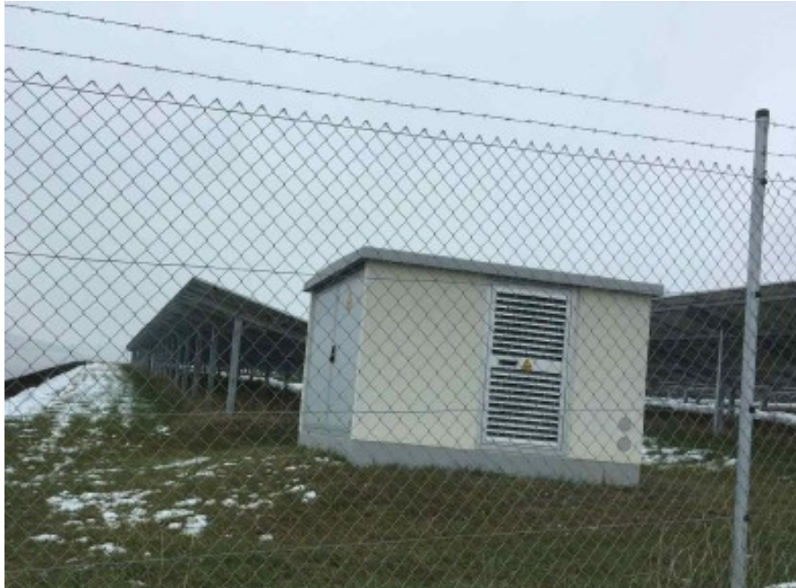
Die Trafostation einer gleichartigen Photovoltaik-Freiflächenanlage. Der Trafo ist deutlich niedriger und schmaler als die Modultische. Die Wechselrichter und Schaltschränke werden nicht sichtbar unter den Modultischen montiert.
